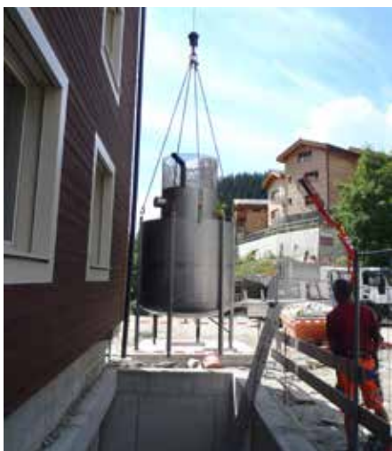
Das Filtermodul der Abwasserwärmerückgewinnung wird im Schacht positioniert. (Bild: Lauber Iwisa AG)
