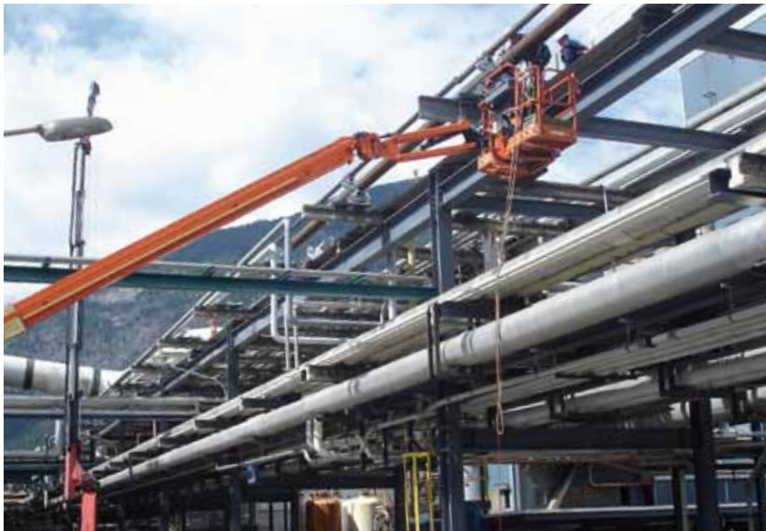
Integration in die bestehende Rohrstrasse Lonza
