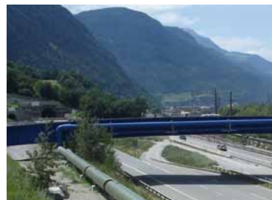
Aufhängung an der Brücke zu Brigerbad
