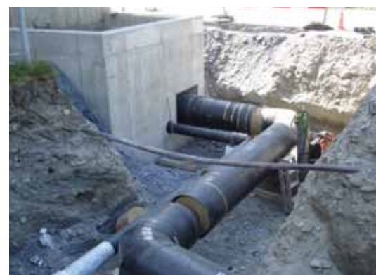
Erdverlegung Anschluss KVA Gamsen
